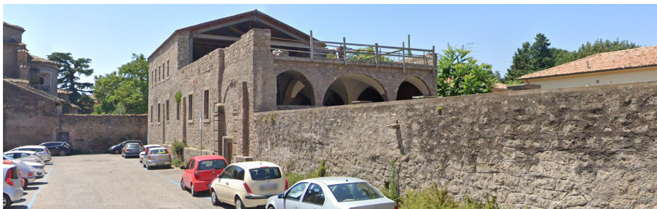
Intervento n. 58 –Restauro mura civiche e completamento delle ex scuderie papali di piazza Sallupara e riqualificazione aree adiacenti a Viterbo
